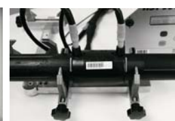
Phase 7 soudure et refroidissement
