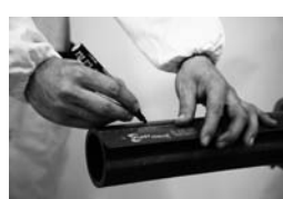
Phase 2 identification de la zone de grattage
