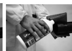
Phase 4 nettoyage des éléments à souder
