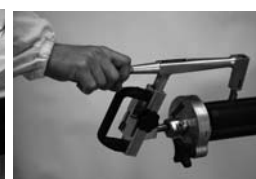
Phase 3 ou grattage mécanique
