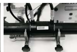
Fase 7: Soldadura y refrigeración
