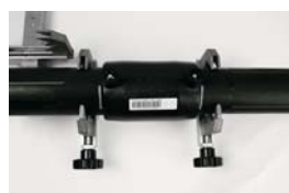
Fase 5 posizionamento ed allineamento
