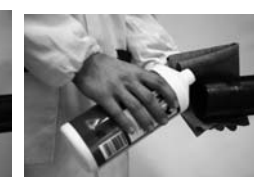
Fase 4 pulizia degli elementi da saldare
