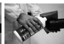
Fase 4: Limpieza de los elementos de soldadura
